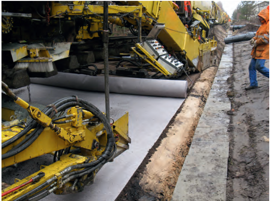
Abb. 3: Einbau des Vliesstoffes mit gleichbleibend hoher Qualität
