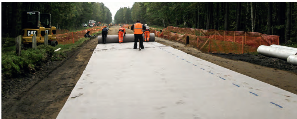
Abb. 4: Gleisloser konventioneller Einbau des Vliesstoffes
