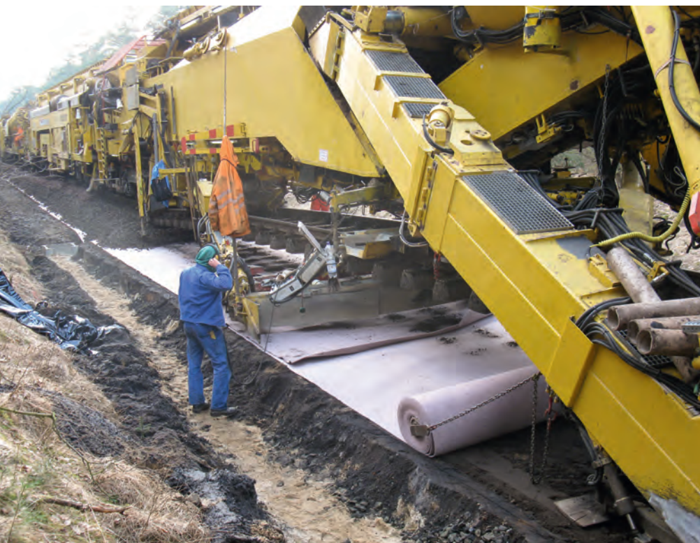
Abb. 2: Gleisgebundener Einbau des Vliesstoffes
