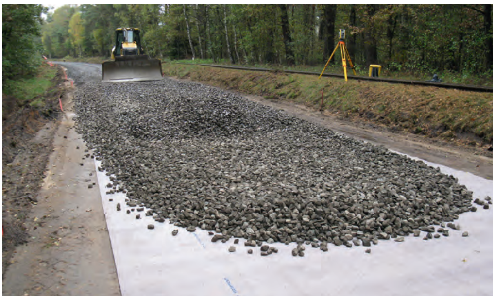
Abb. 5: Vor-Kopf-Einbau des Grundschanters
