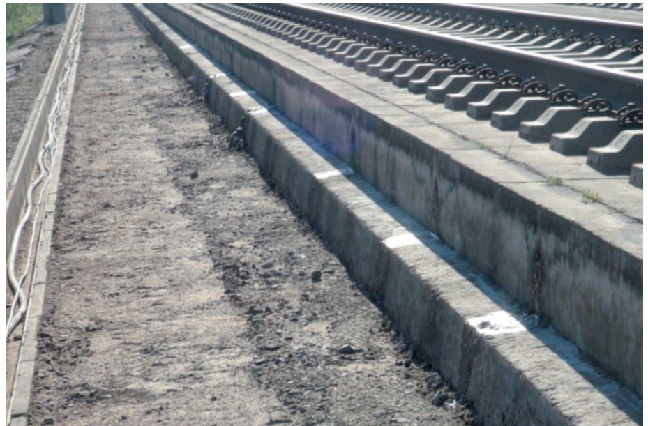
BILD 5: Fotoaufnahme vom 02.08.2013, Zustand der Festschwellenbahn, Bauart Rheda (klassisch), modifiziert System Heilit und Woerner, nach dem Schotterabtrag
