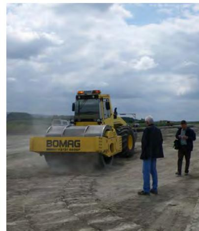
**Bild 7: Ponore – kompakte Hohlräume (links, mitte); Walze mit Polygonbandage (rechts)**
