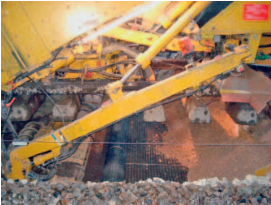
Bild 22: Einbau eines Tragsystems mit Geogitter
