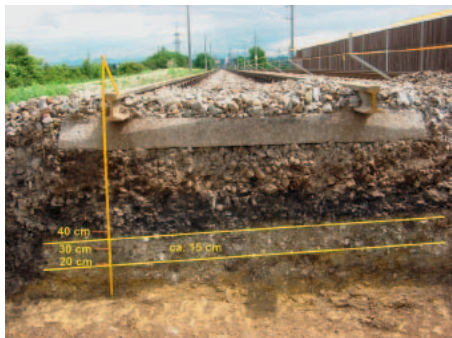
Bild 19: Aufgrabung bei Umbau 2005
