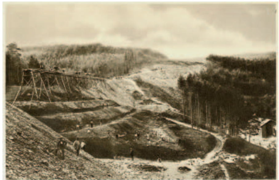
Bild 7: Schüttgerüst bei einer Dammschüttung an der Strecke Weimar-Gera um 1875
