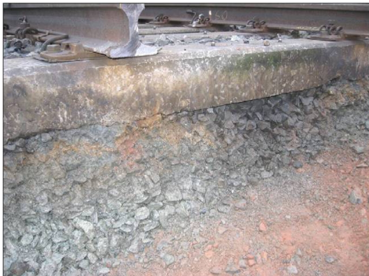
Abbildung 1: Geschädigte Schotterbettung
